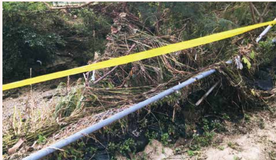
白比川河川氾濫後の様子
