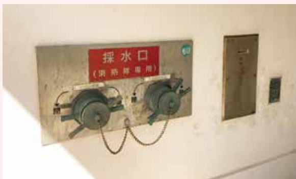
役場地下1階にある採水口
