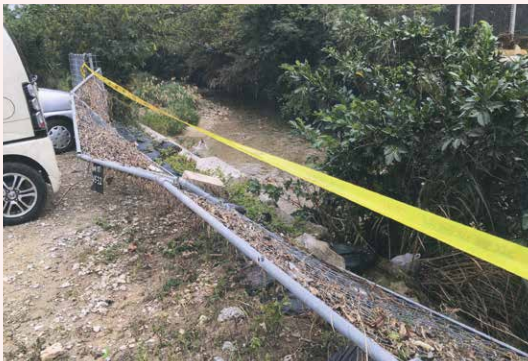
氾濫した白比川沿いの壊れたフェンス
