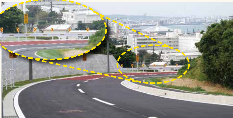
転落防止柵の早急な設置を！
