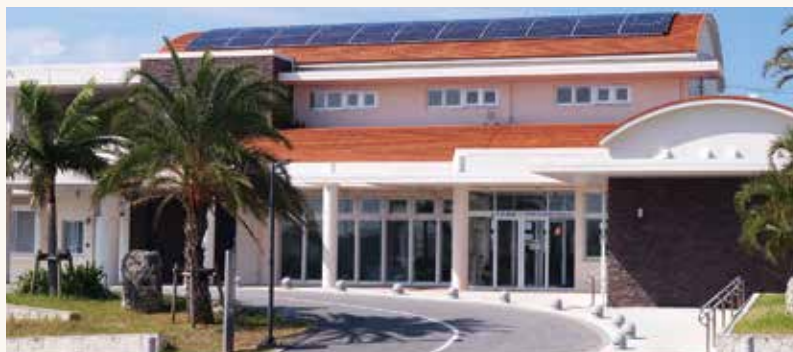
上下水道庁舎
