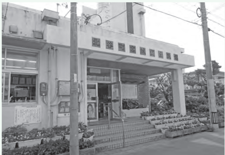
建て替えが望まれる宮城区公民館
