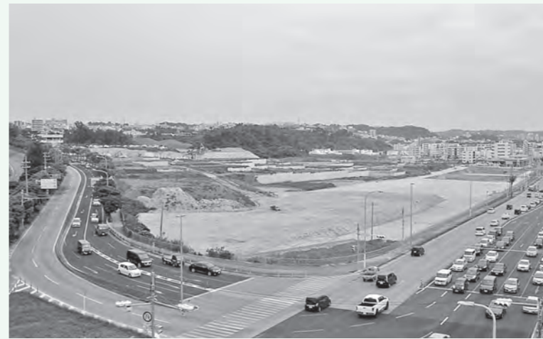
整備が進む桑江伊平土地区画整理地区
