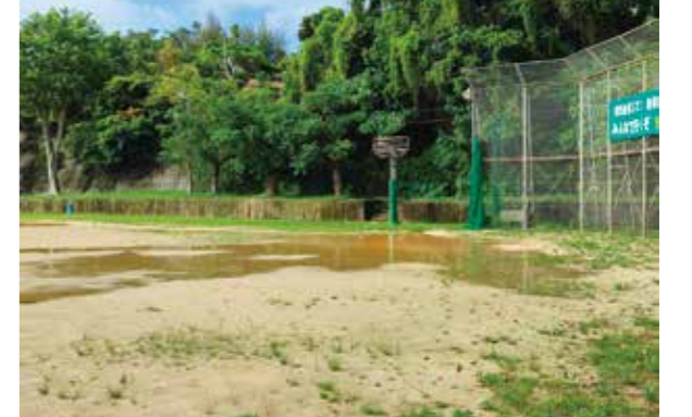
早期の施設修繕が望まれる
