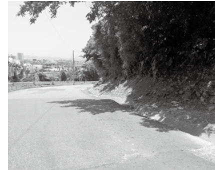
危険がいっぱい17号線仮設道路
