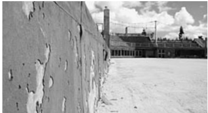
インターハイに向けて改修工が必要なソフトボール場
