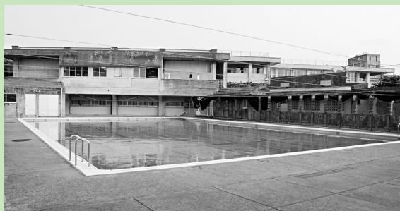
ろ過装置改修される北谷中学校プール
