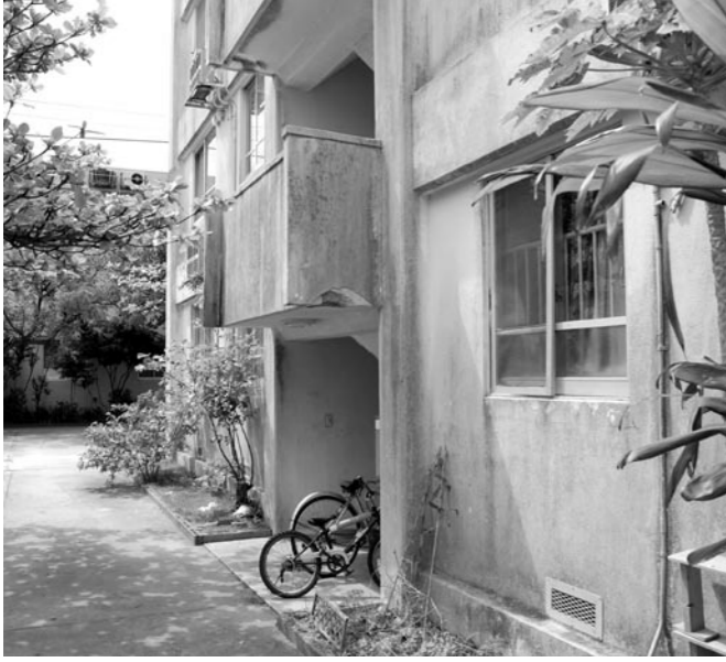
建替予定の町営砂辺団地（平成27年度完成予定）
